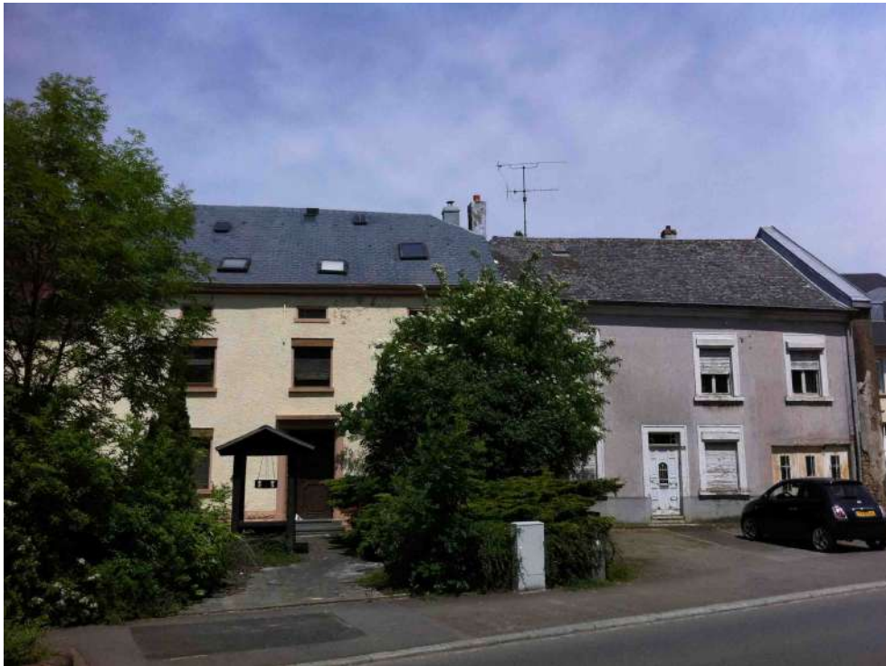
Img. 15 Bâtiments n°24 et n°26 à démolir pour réaliser l'accès « Rue de la
