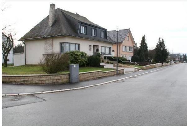
Figure 12 : typologie des constructions avoisinantes au site
